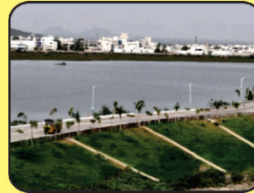
MINI TANK BUND
